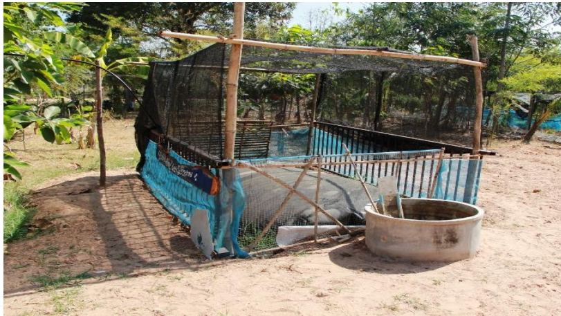
รูปที่ 5 บ่อหมักแก๊สชีวภาพแบบถุงพลาสติก ขนาด 8 คิว
